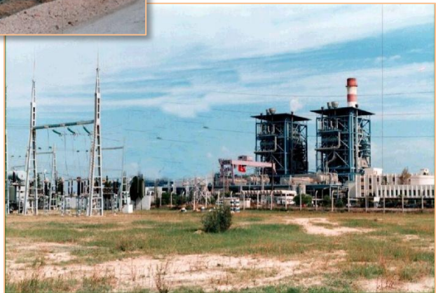
Centrale à cycle combiné de Souss (360MW)
