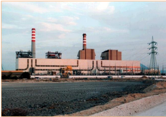
Centrale thermique de Rades (640 MW)
