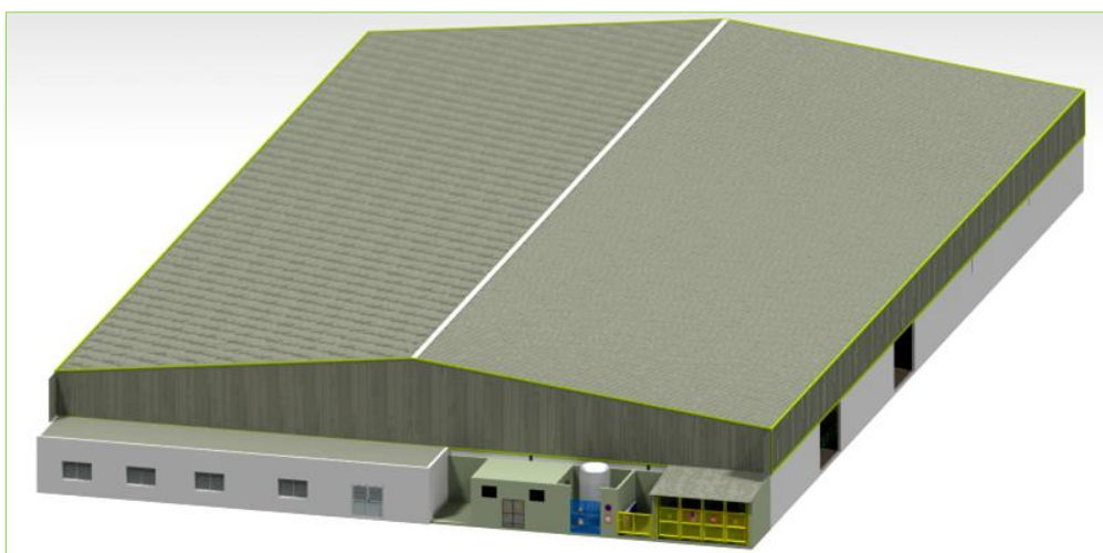
Fig.38 – ATC couvert par bardage
