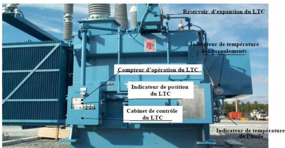
Figure (1.12) : Transformateur régulateur en charge
