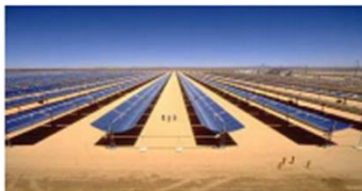
Centrale thermosolaire ABM
