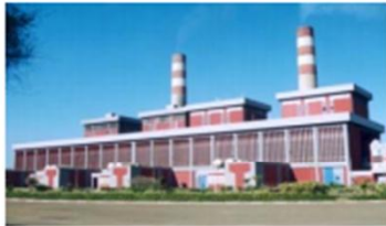
Centrale thermique de Mohammedia
