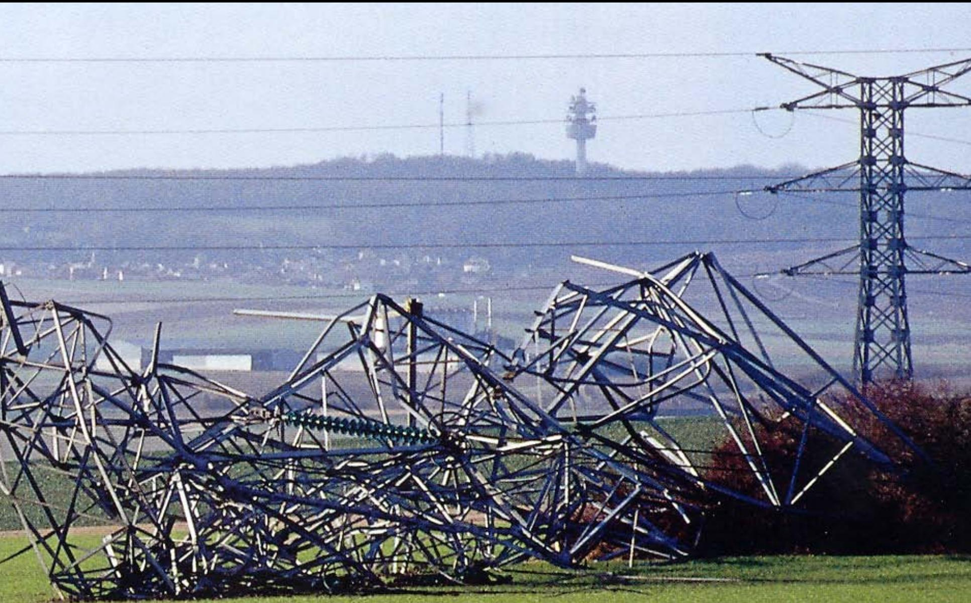
Suite à la tempête de 1999 : Renforcement de la tenue mécanique des lignes pour un vent de 150 km / h. et mise en œuvre de pylones anti-cascade pour prévenir l'effet « domino »(RTE).
